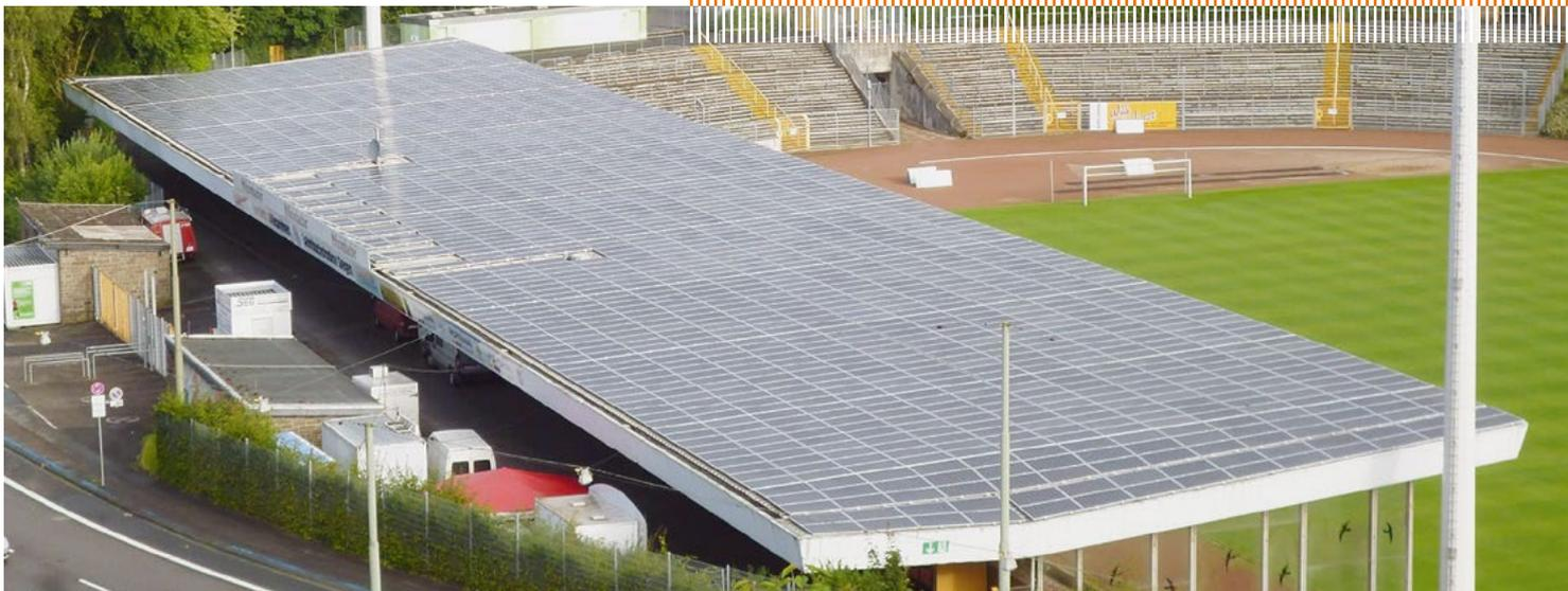
Die Photovoltaik-Anlage auf dem Tribürendach des Leimbachstadions produziert etwa 480.000 Kilowattstunden Strom im Jahr.
