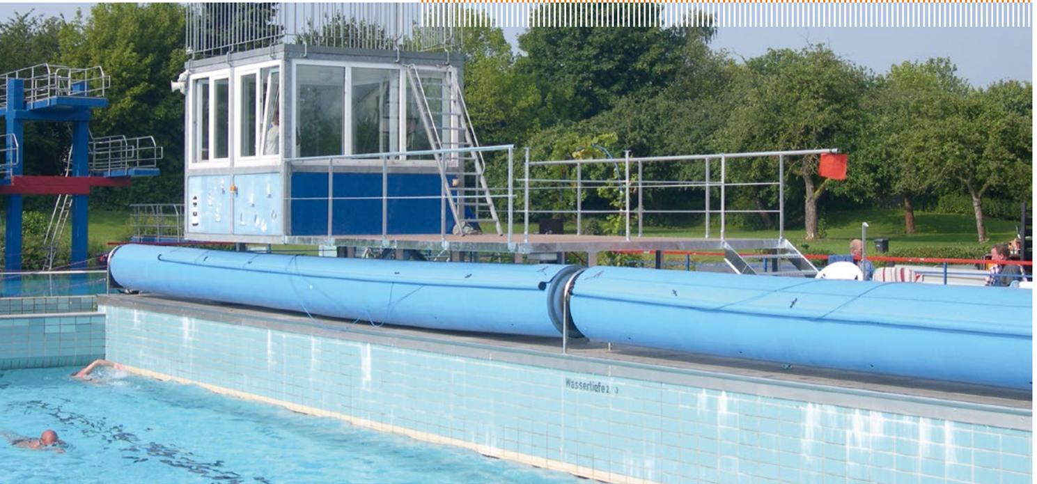
Eine Becken-Abdeckung kann den Energieverbrauch in Freibädern deutlich reduzieren.
